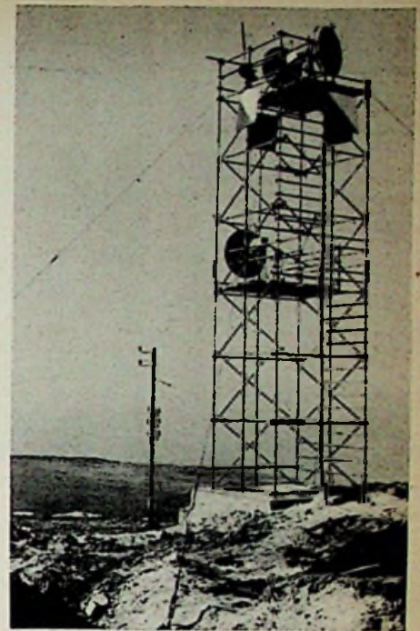
Bild 2. Relaisstelle Blanc-Nez mit Doppelpfangsanlage
