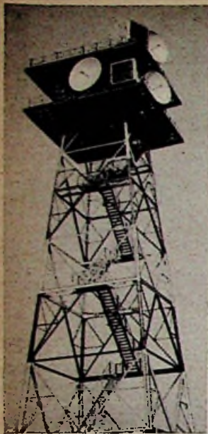
Links: Bild 5. Richtfunk-Knotenpunkt Wuppertal mit Parabolspiegelantennen für Fernsehen und impulsmodulierte Mehrkanalverbindung sowie neuen Hornantennen für Versuchszwecke
